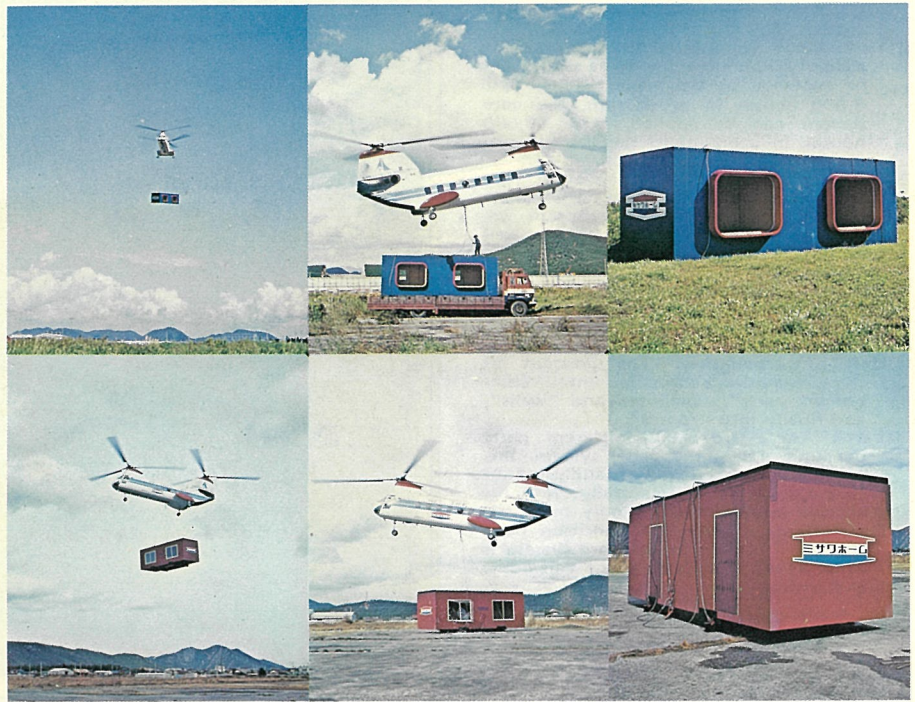
カプセルの輸送と強度テスト air lift of a capsule unit showing its solid monocoque structure
