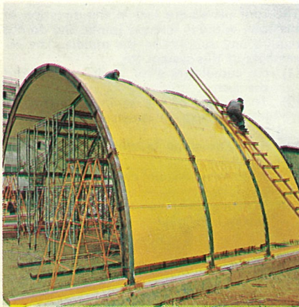
国内での格納庫の組立テスト風景 the trial erection of a hanger in Japan
