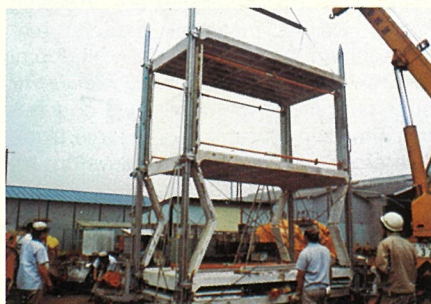
写真 4：同構法による建方実験
