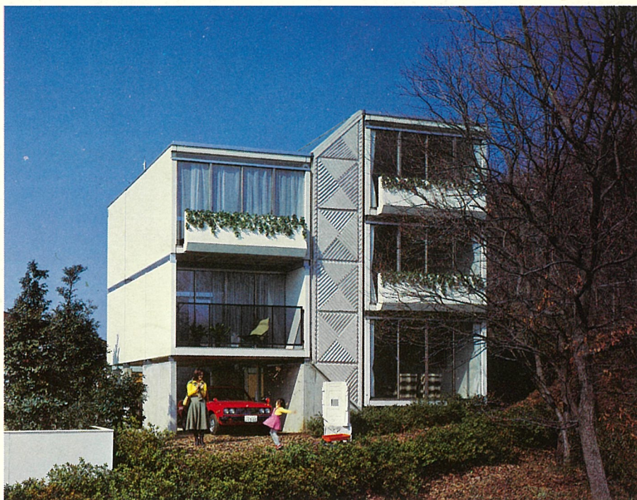
写真 2：U字型ユニット構法による 3 階建実験棟(府中市)
