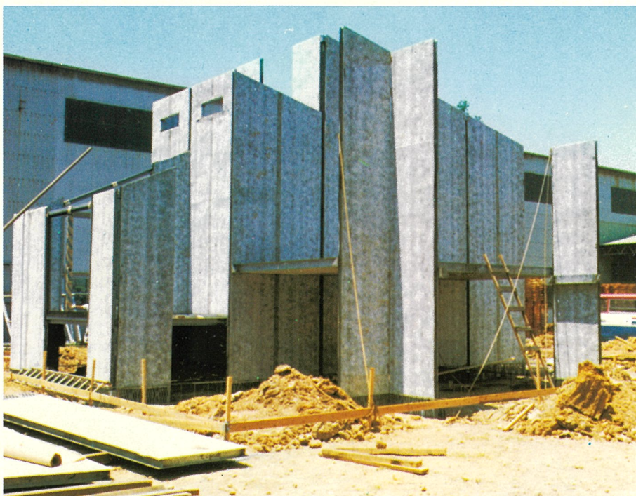
写真1：長尺パネルによる実大住宅建設実験(市川市)
