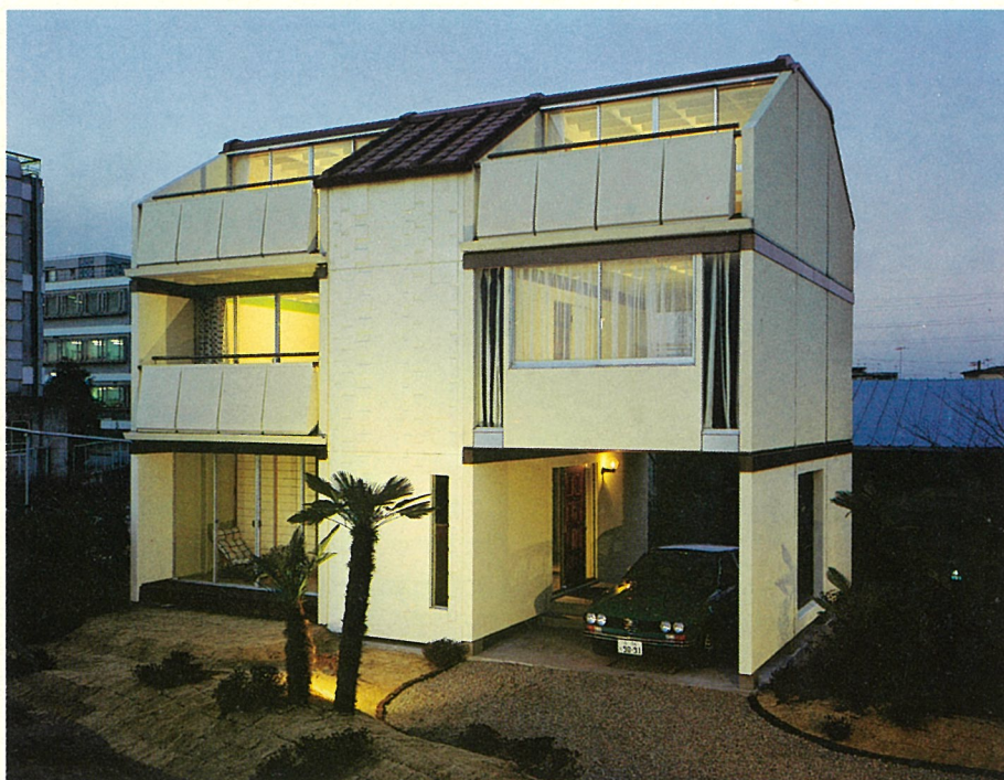
写真1：新カプセル(U字形ユニット)構法による居住実験棟(東京・大田区)
